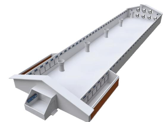
联合纵向通风和在气候条件变化时即室外温度从非常冷变为非常热的时候，可以提供最好的生产力条件。
